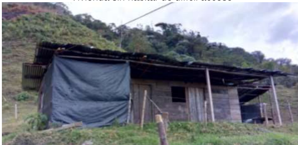
Imágen 32. Vivienda sin habitar de difícil acceso
