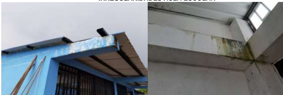
Registro fotográfico tomado en visita.
