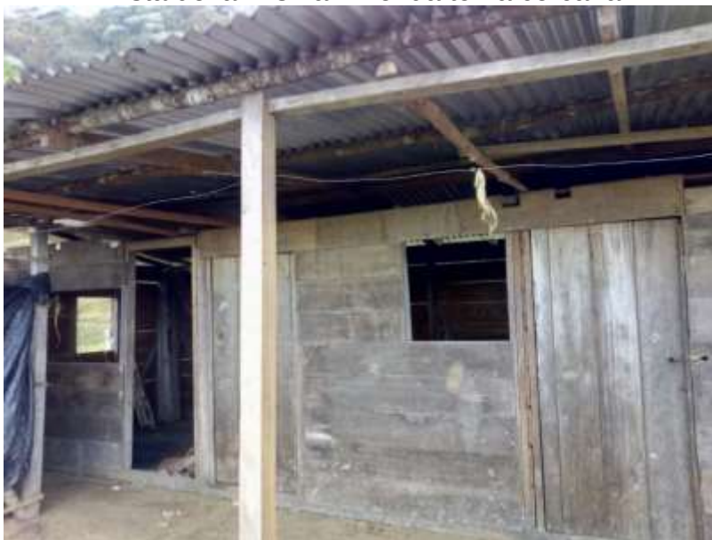
Imágen 33. Vista de la misma vivienda toma cercana
