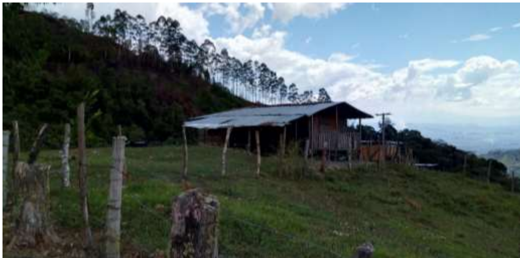
Imagen 30. Vivienda sin habitar
