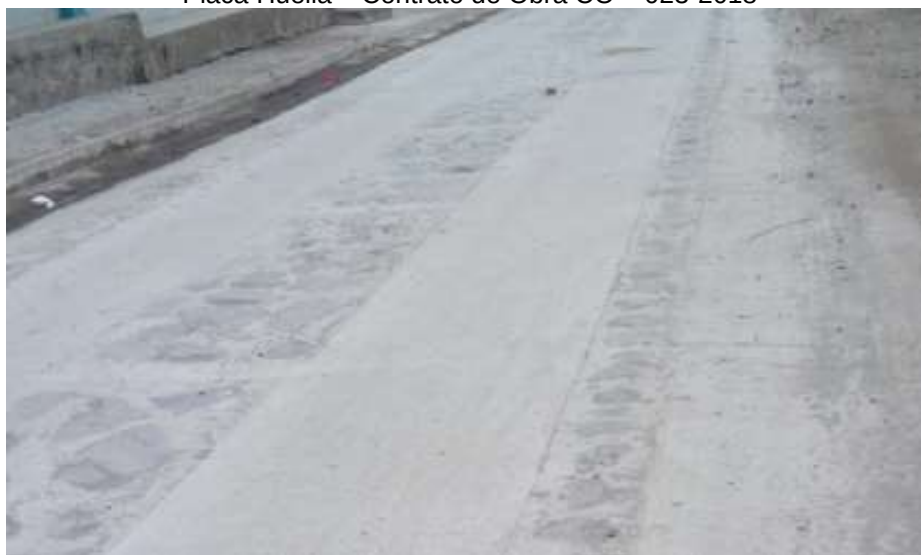
Imagen 16. Placa Huella – Contrato de Obra CO – 023-2018
