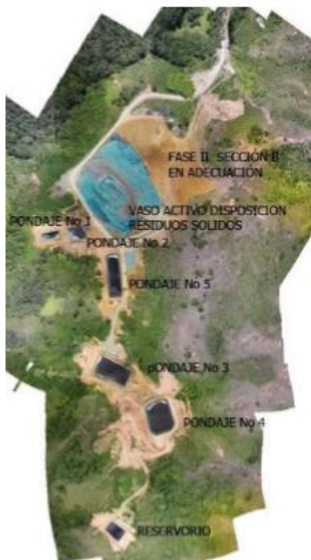
Ilustración 38. Relleno sanitario Los Picachos- vereda la Yunga.
