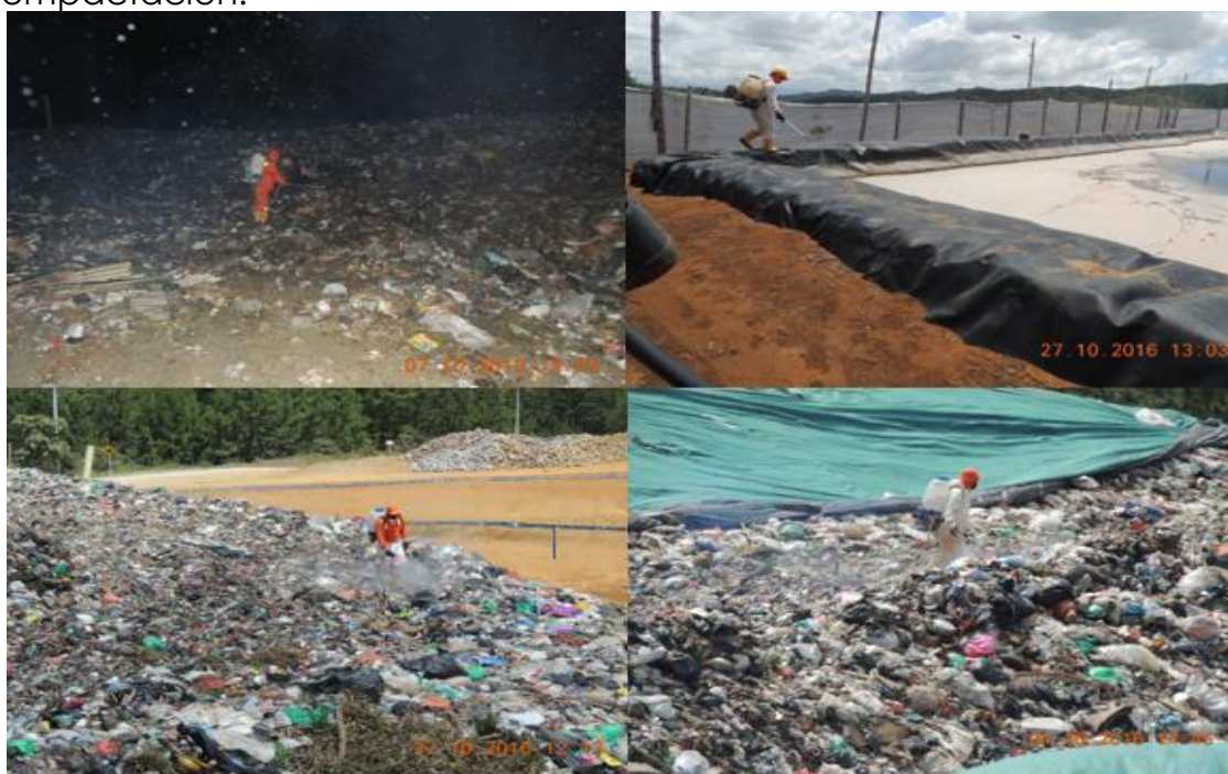
Ilustración 42. Fumigación de residuos sólidos en la descarga, regados y compactación.
