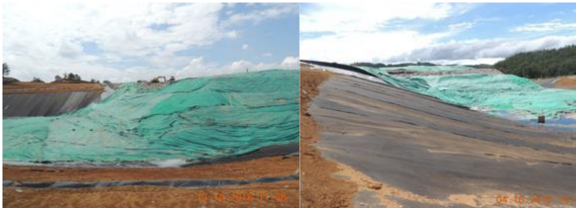
Ilustración 41. Material de cobertura diaria Relleno Sanitario Los Picachos.
